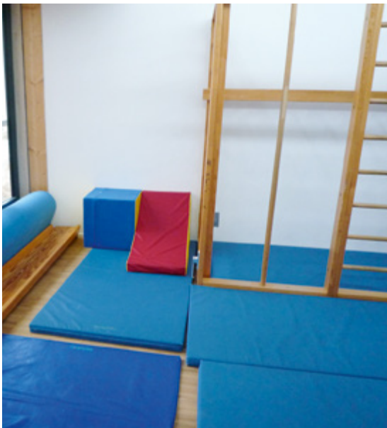
Abb. 47: Bei diesem Gerät besteht die Gefahr des Aufpralles auf kleinflächige, harte Teile. Die Matten sind z. T. ungeeignet und nicht gegen Verrutschen gesichert.
